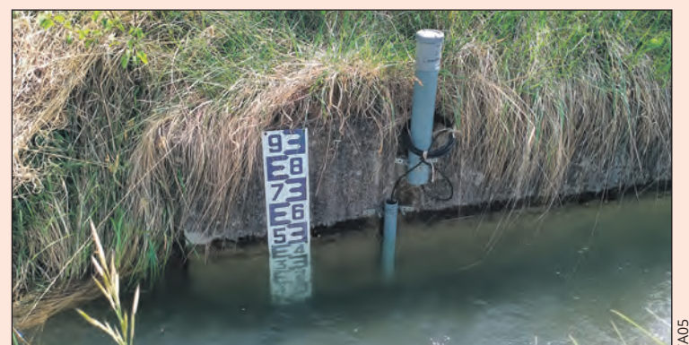
Instrumentation d'un canal gravitaire dans le Buëch avec une sonde de pression et température à télégestion.
