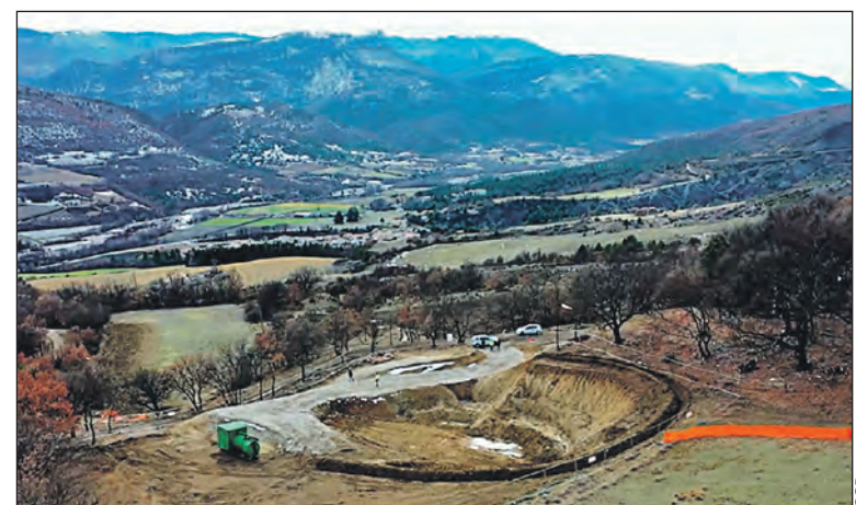
Extension réseau SCP, Vallée du Jabron, 2023.
