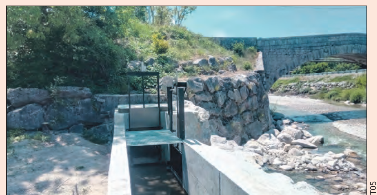
La nouvelle prise d'eau de l'ASA de la Bâtie-Montsaléon qui permettra une régulation plus fine et contrôlée des prélèvements sur le Petit Buëch.
