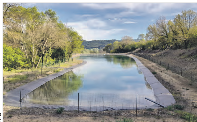
Retenue collinaire, Reillanne, 2020.
