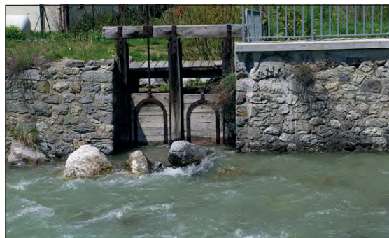
Prise d'eau sur la Durance à Briançon.
