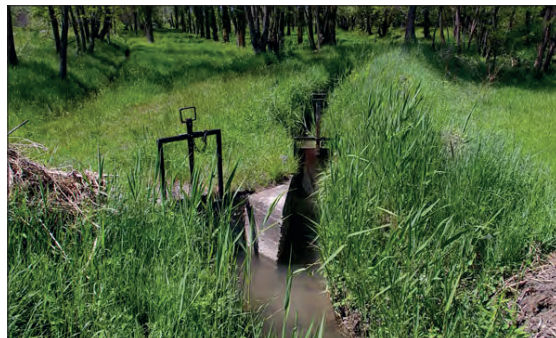
Un bel exemple de martelières dans les Hautes-Alpes.
