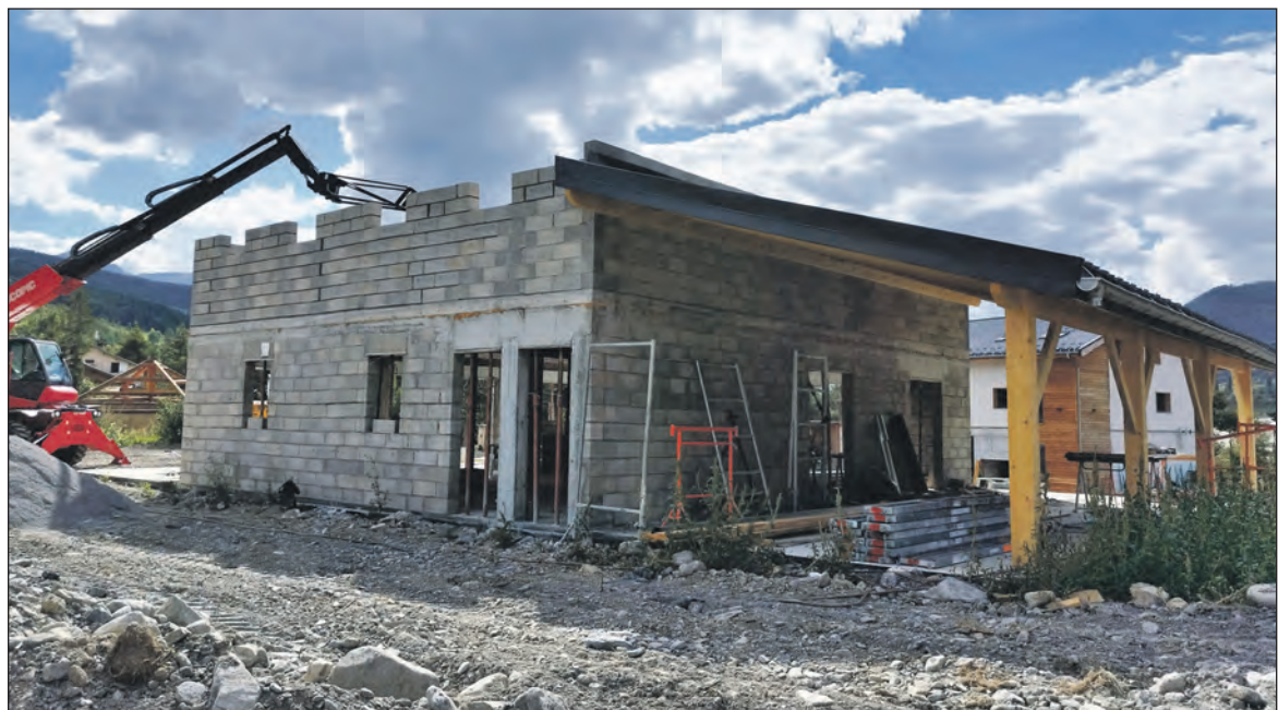
Le bâtiment de Jonas Kluge à Jausiers est en cours de construction. La structure sera en béton, la charpente en bois et sera recouvert de chaux et de paille de lavande. Avant de se lancer, il en avait même réalisé une maquette, en bois, bien évidemment.
