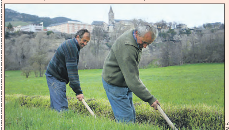
Les adhérents des ASA sont partie prenante des assises de l'eau. L'entretien des canaux est essentiel, comme ici à Embrun.
