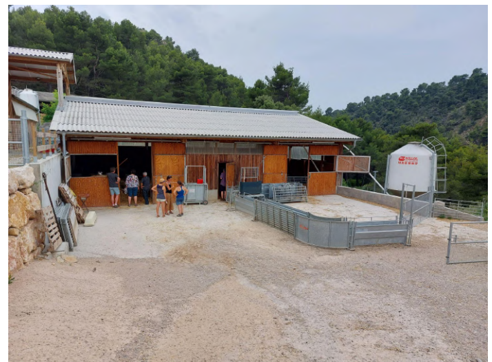
Bergerie bois avec couloir de tri mobile
